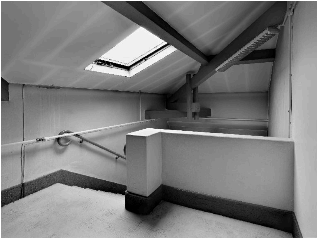
Bâtiment rue Duhamel, comble : dernier palier de l'escalier nord
