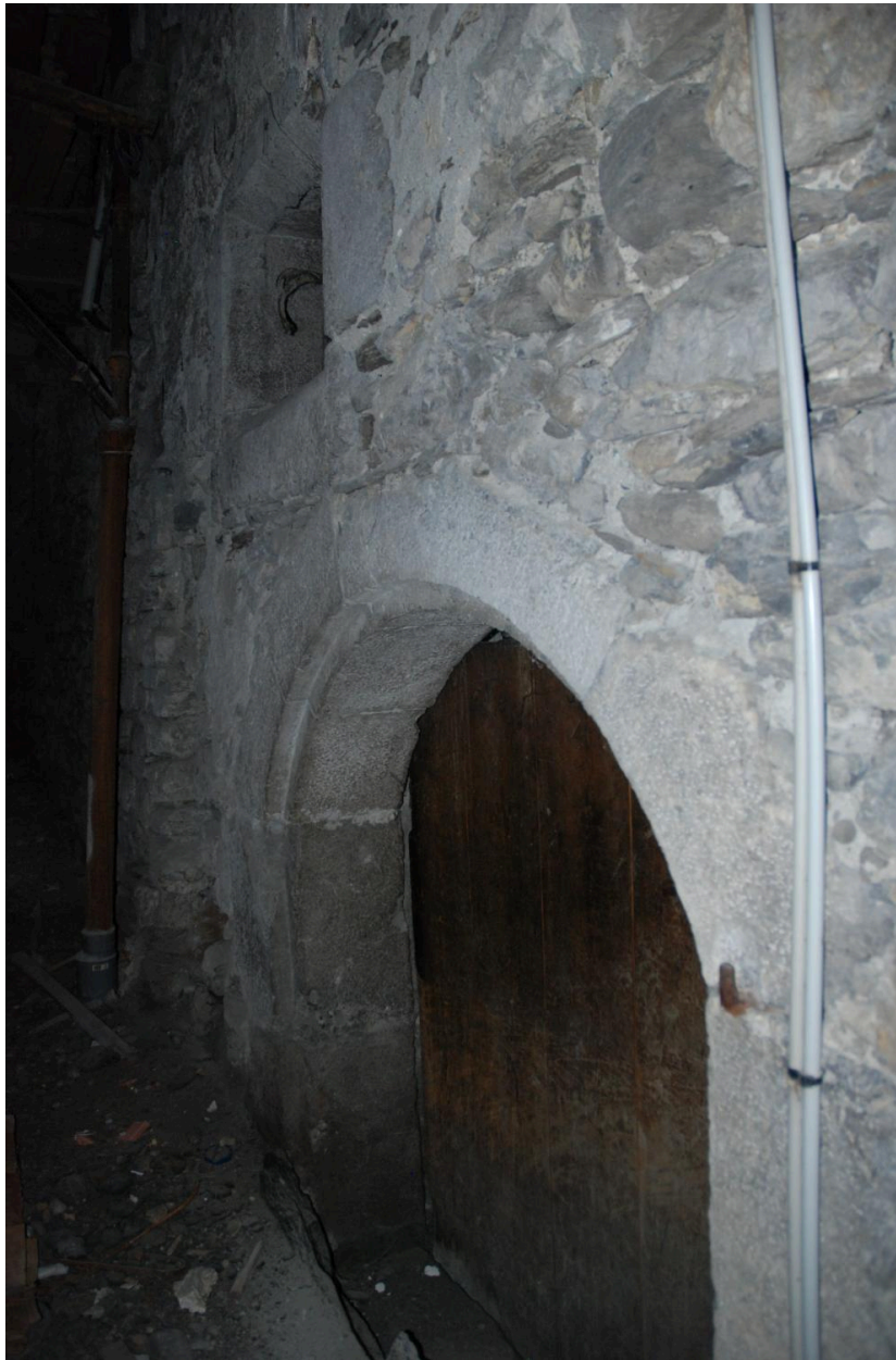
Porte de cave donnant sur le passage commun à l'arrière des maisons du front ouest de la place Charles-Albert.
