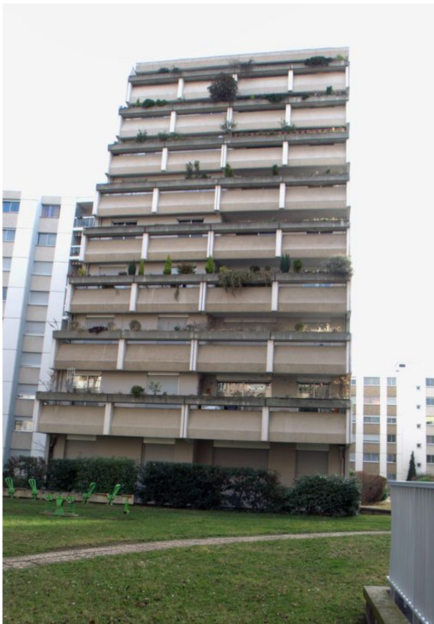
Elévation ouest du corps de bâtiment sud, depuis l'ouest
