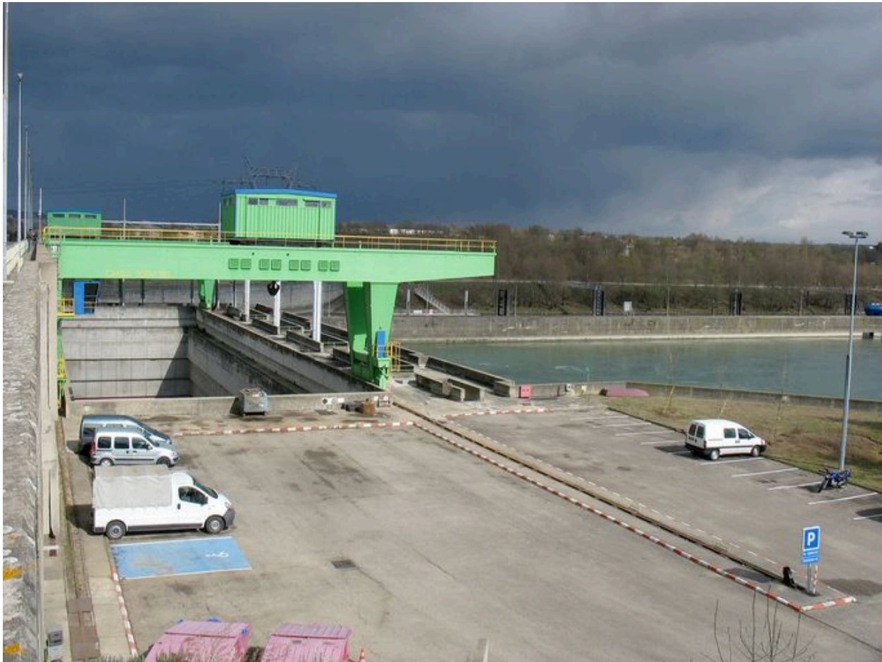
Centrale hydroélectrique, vue partielle, côté aval (depuis la rive droite)
