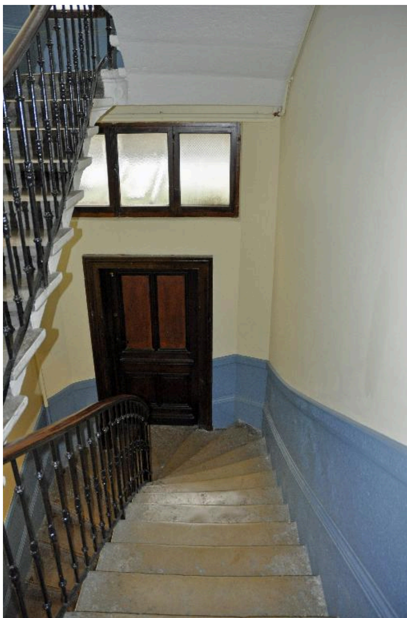
Vue intérieure : la première révolution de l'escalier
