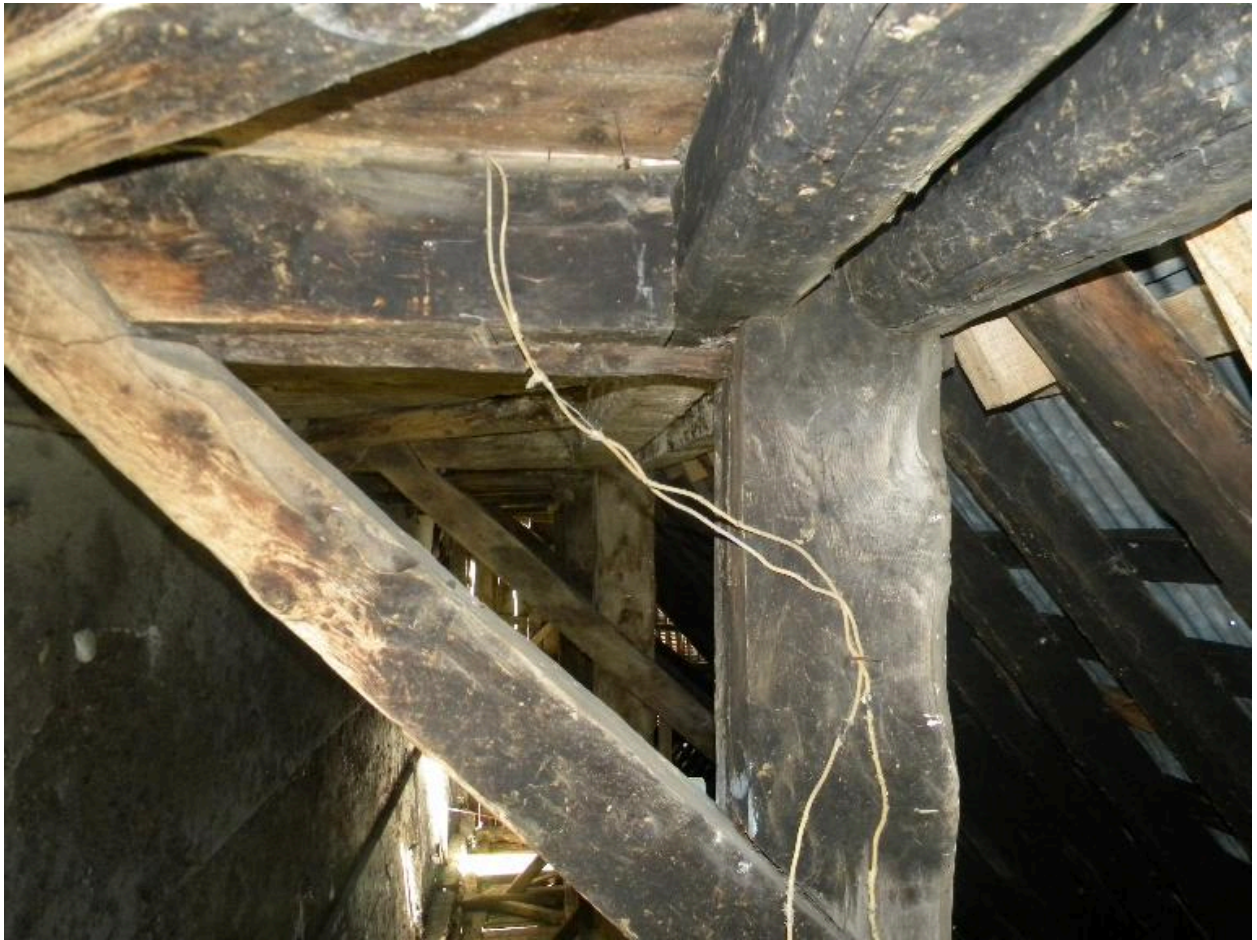
Etable, vue intérieure : détail de charpente.
