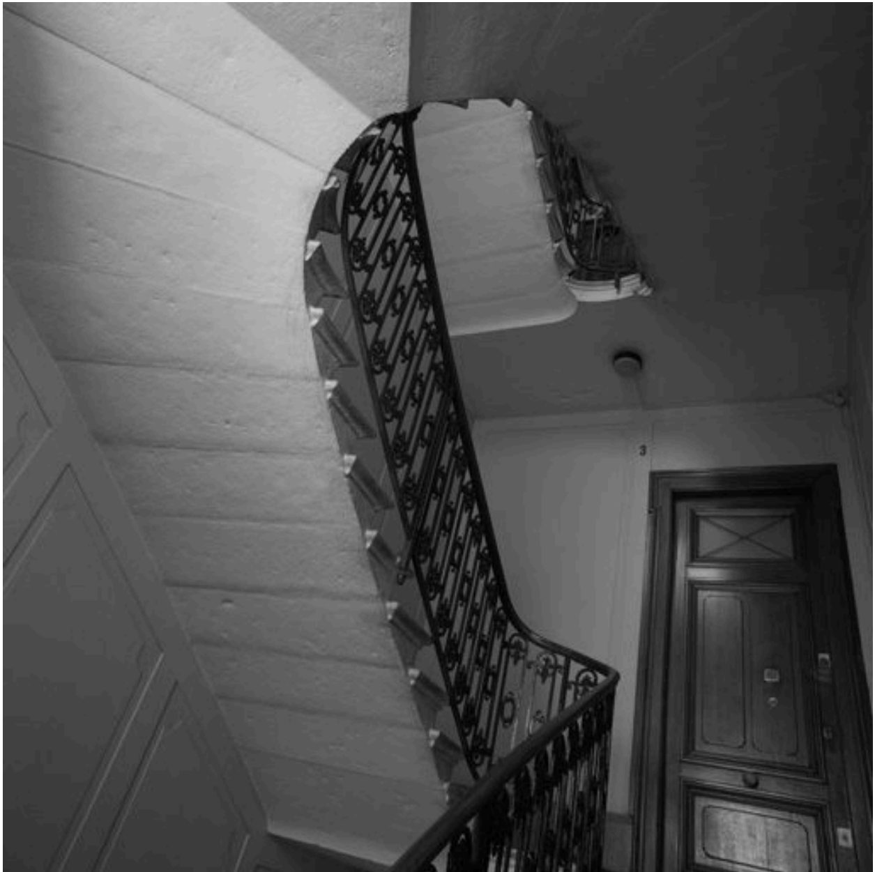
Escalier secondaire sur la rue Saint-Nizier, vue par-dessous d'un étage
