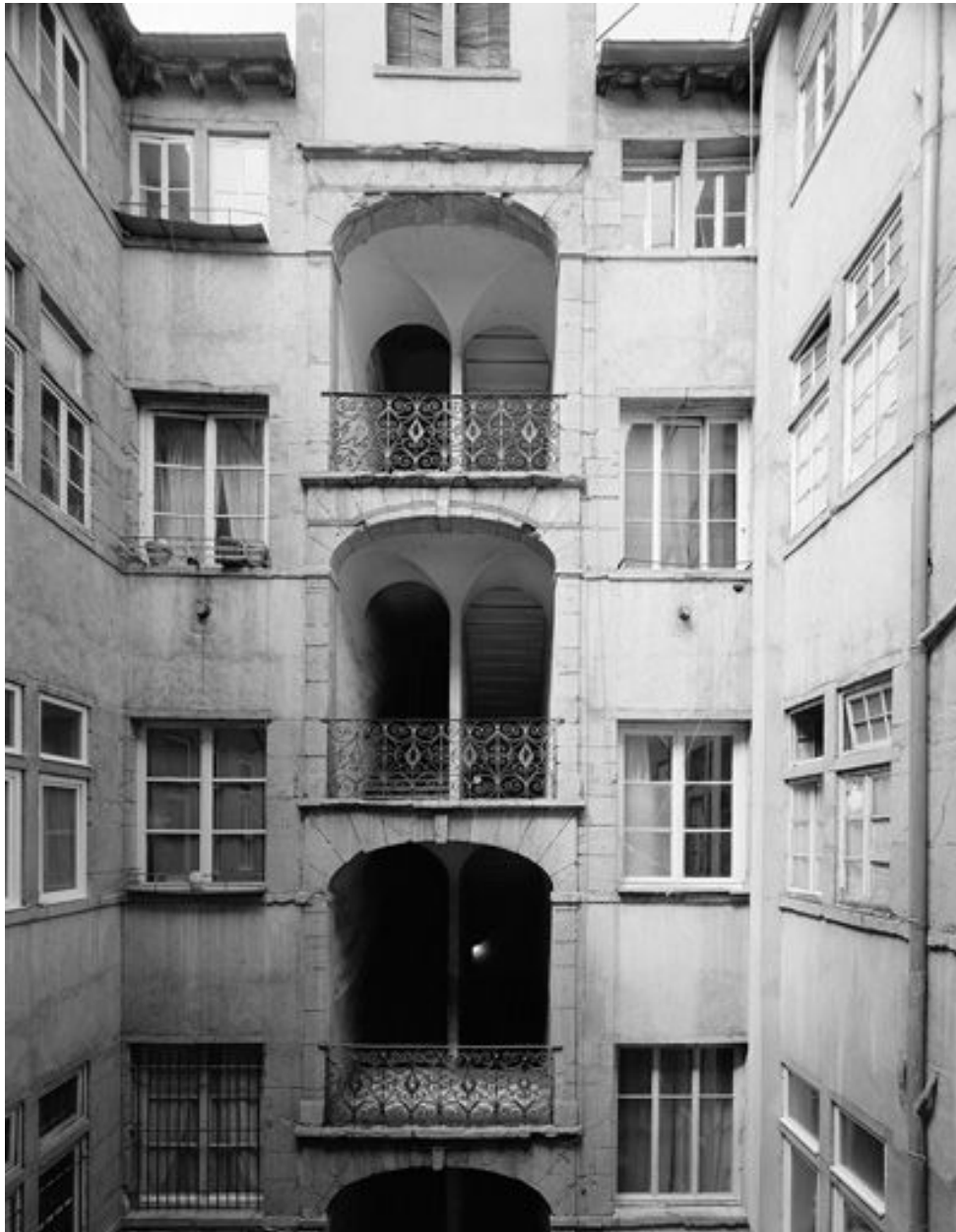
1er corps de bâtiment, élévation sur cour, niveaux 2 à 5
