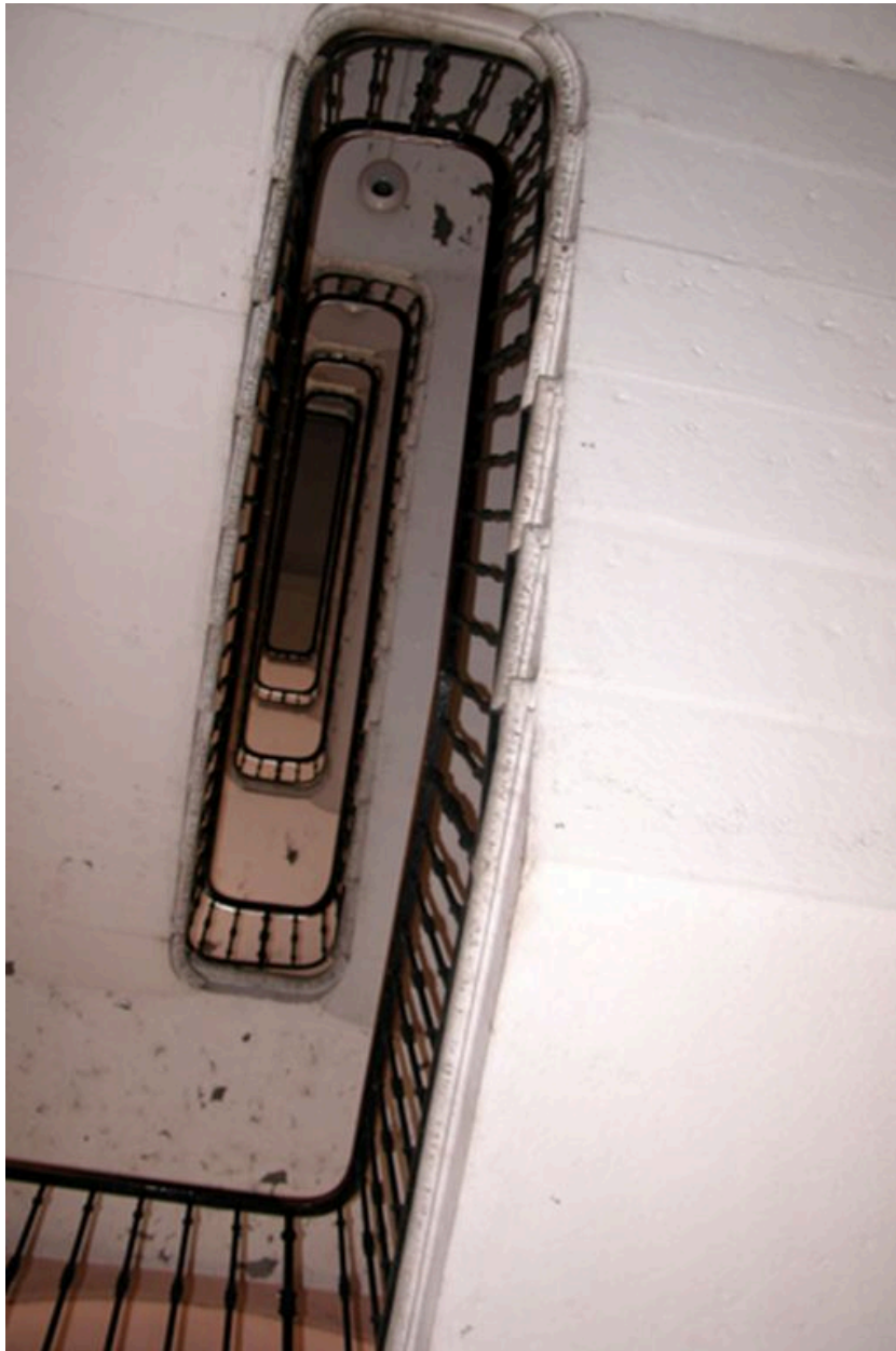
Vue de la cage d'escalier
