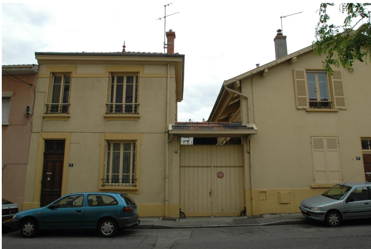
Façade principale usine rue Girie
