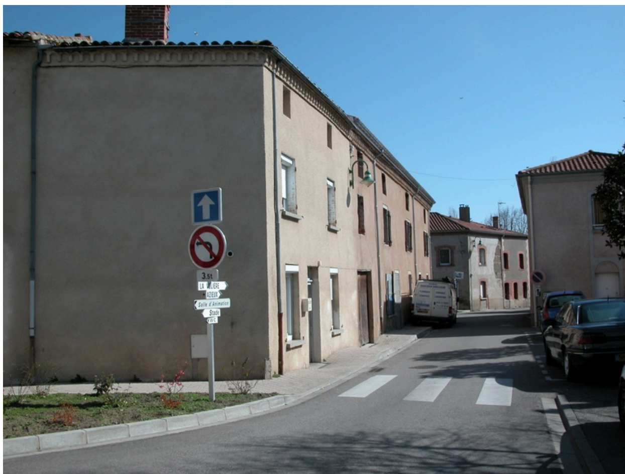
Vue générale depuis l'ouest (parcelle 1986 B2 455 au premier plan).
