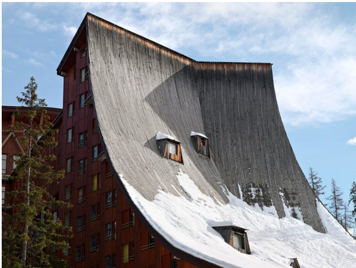
Toiture du corps de bâtiment ouest
