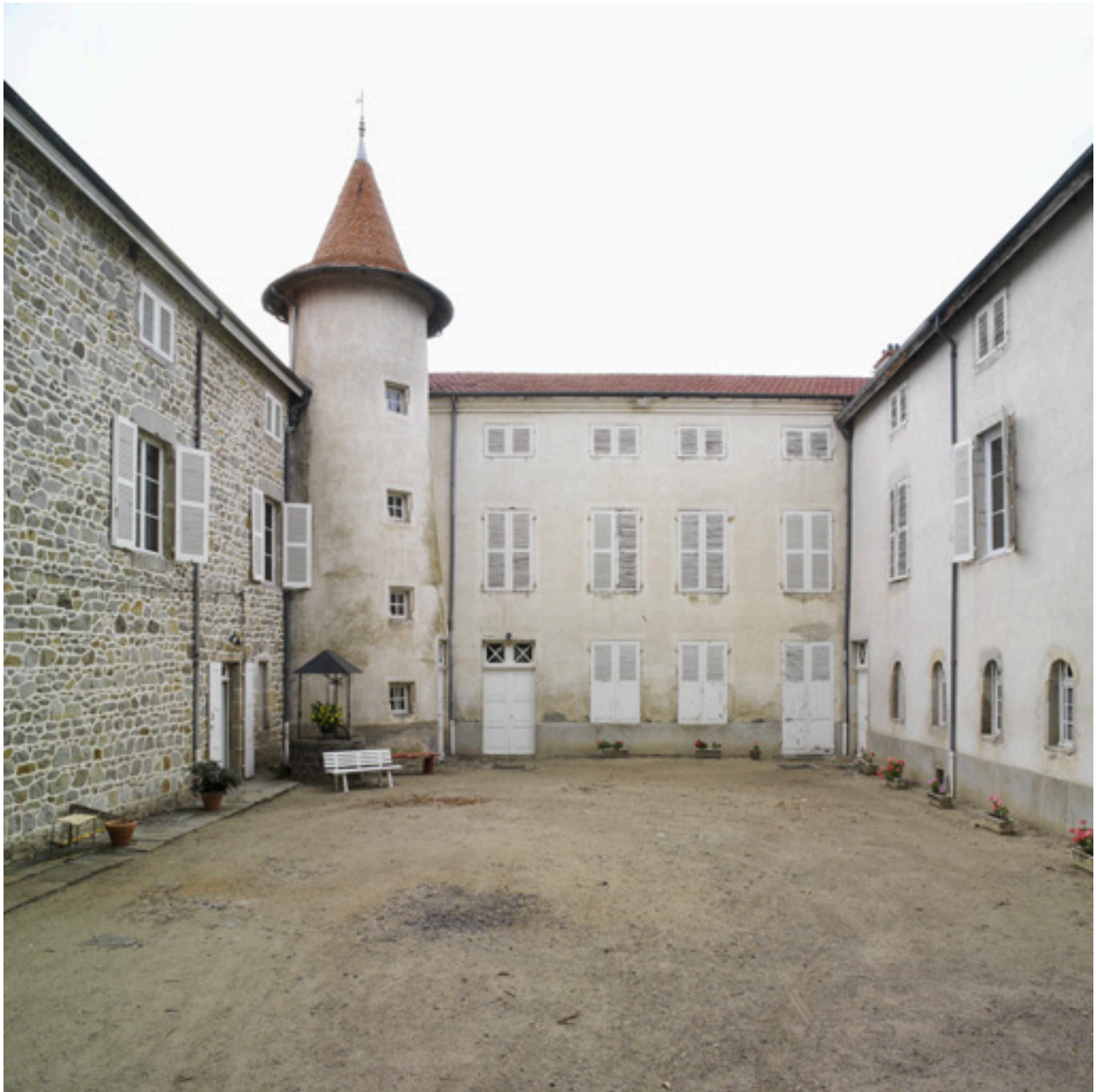
Vue d'ensemble intérieure de la cour, depuis l'est.
