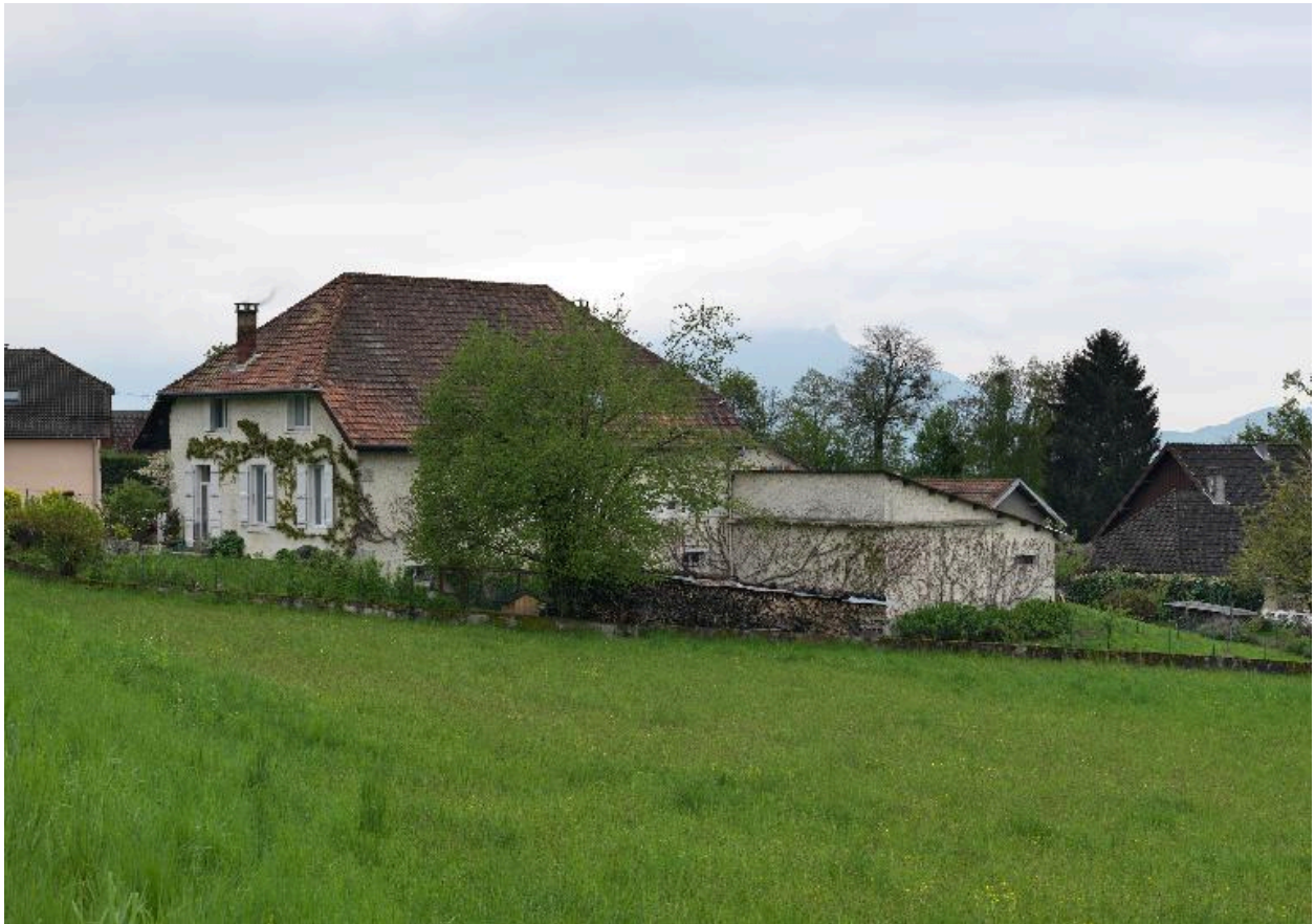
Vue générale depuis l'est.
