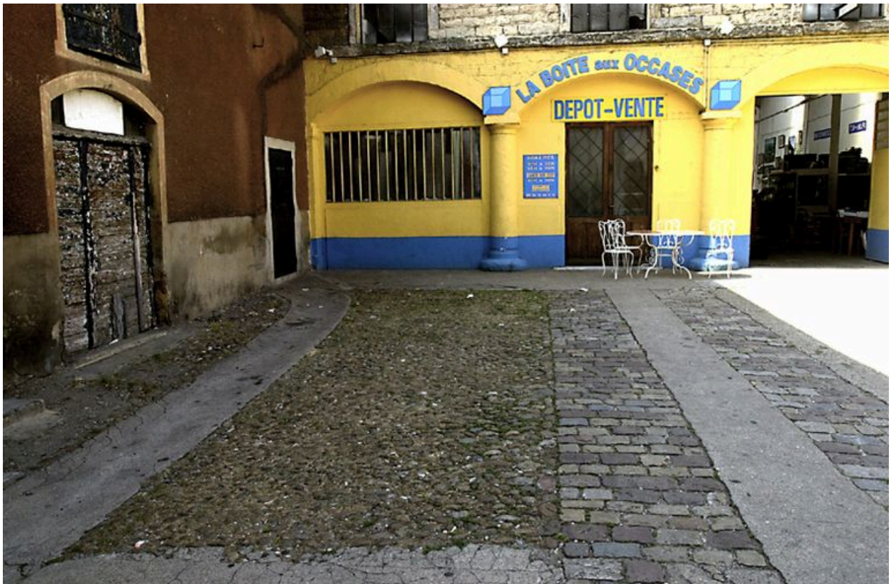
Pavements de la cour
