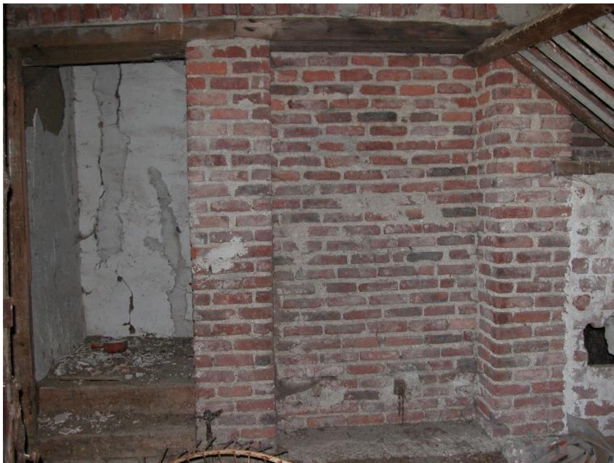
Vue intérieure du mur de refend du rez-de-chaussée.
