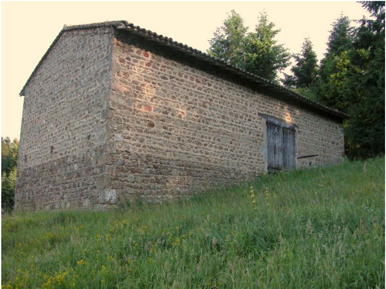
Vue d'ensemble de la jasserie de trois quarts nord-est.
