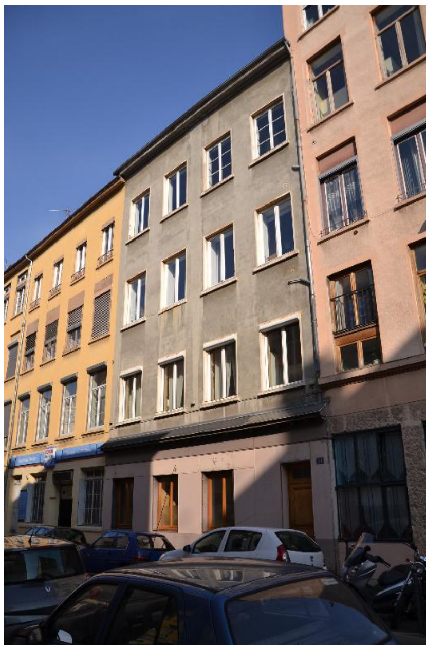
Vue d'ensemble façade sud
