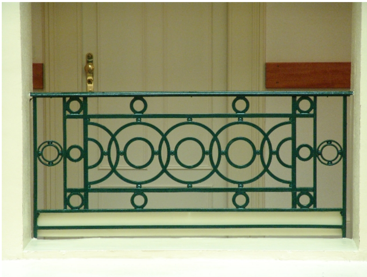
Atrium : garde-corps du 4e étage
