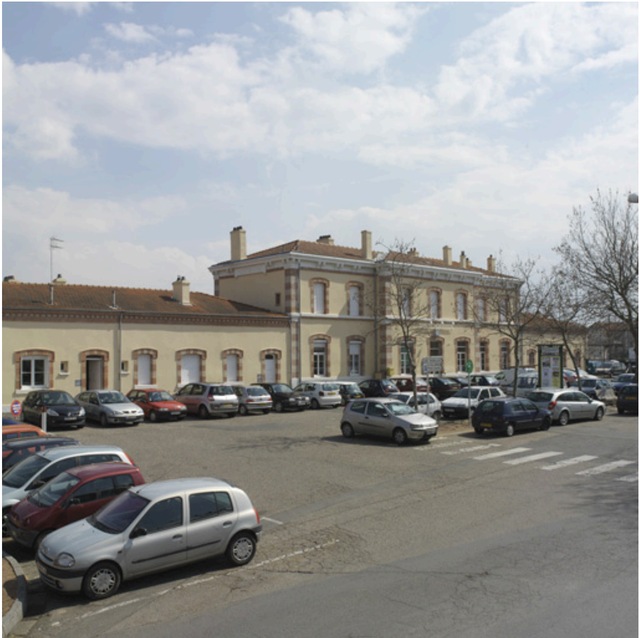
Vue partielle de la gare de voyageurs depuis l'avenue de Pleuvev.
