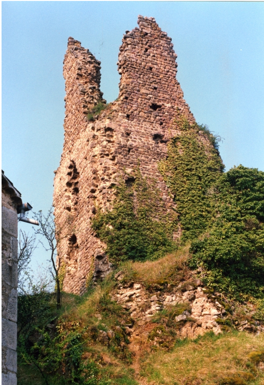
Photographies du donjon d'Ecotay avant restauration. Vue nord-est.
