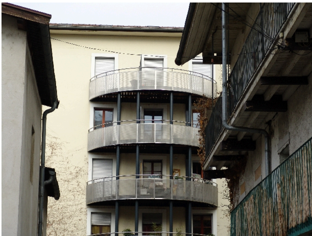
Nouveaux balcons postérieurs
