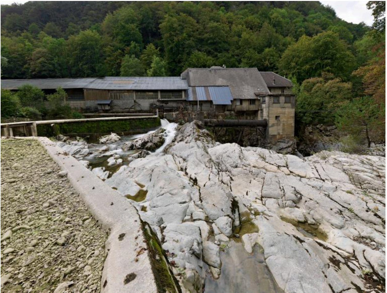
Vue générale de la scierie depuis l'est.
