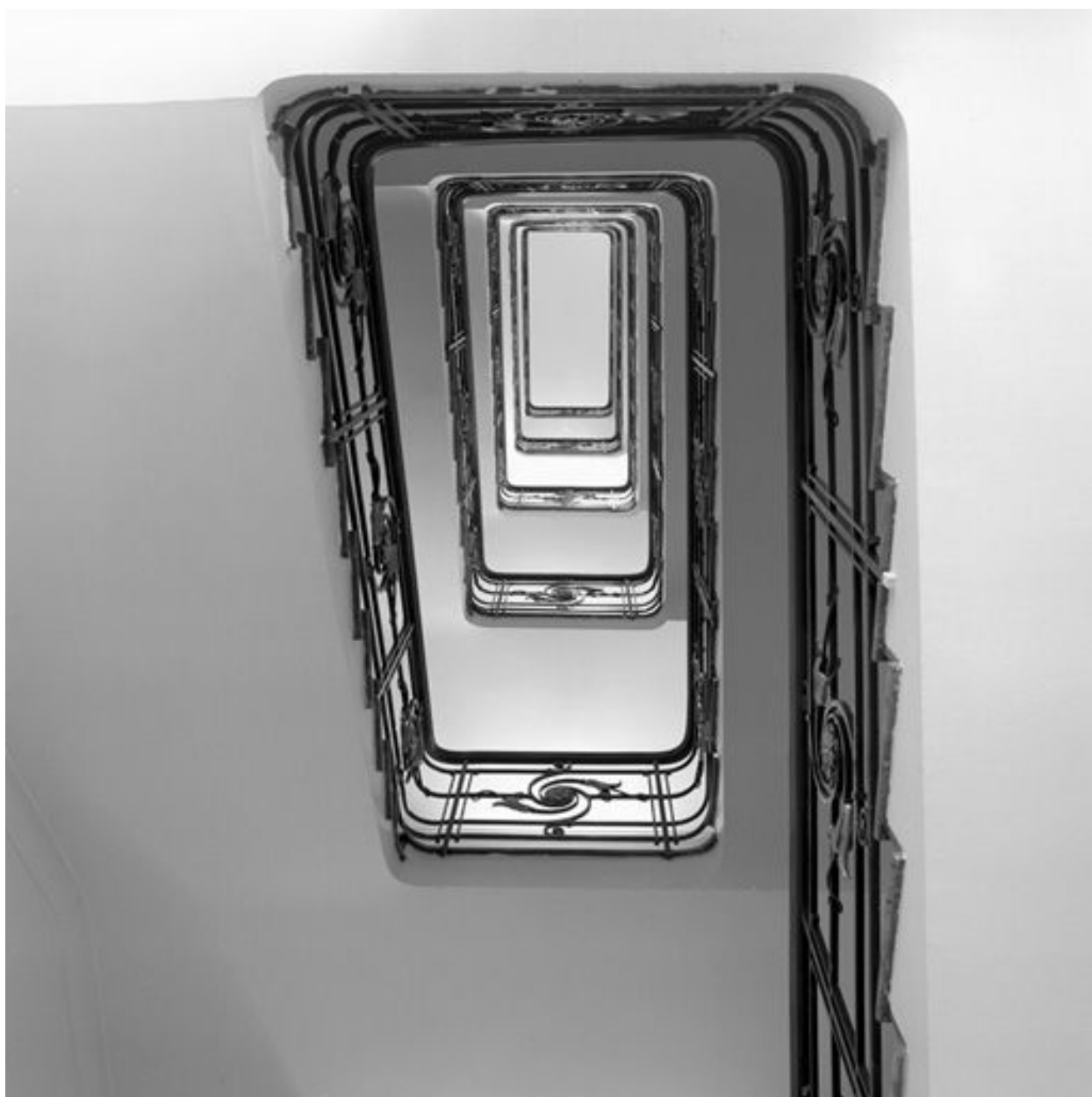
Vue de l'escalier en contre-plongée
