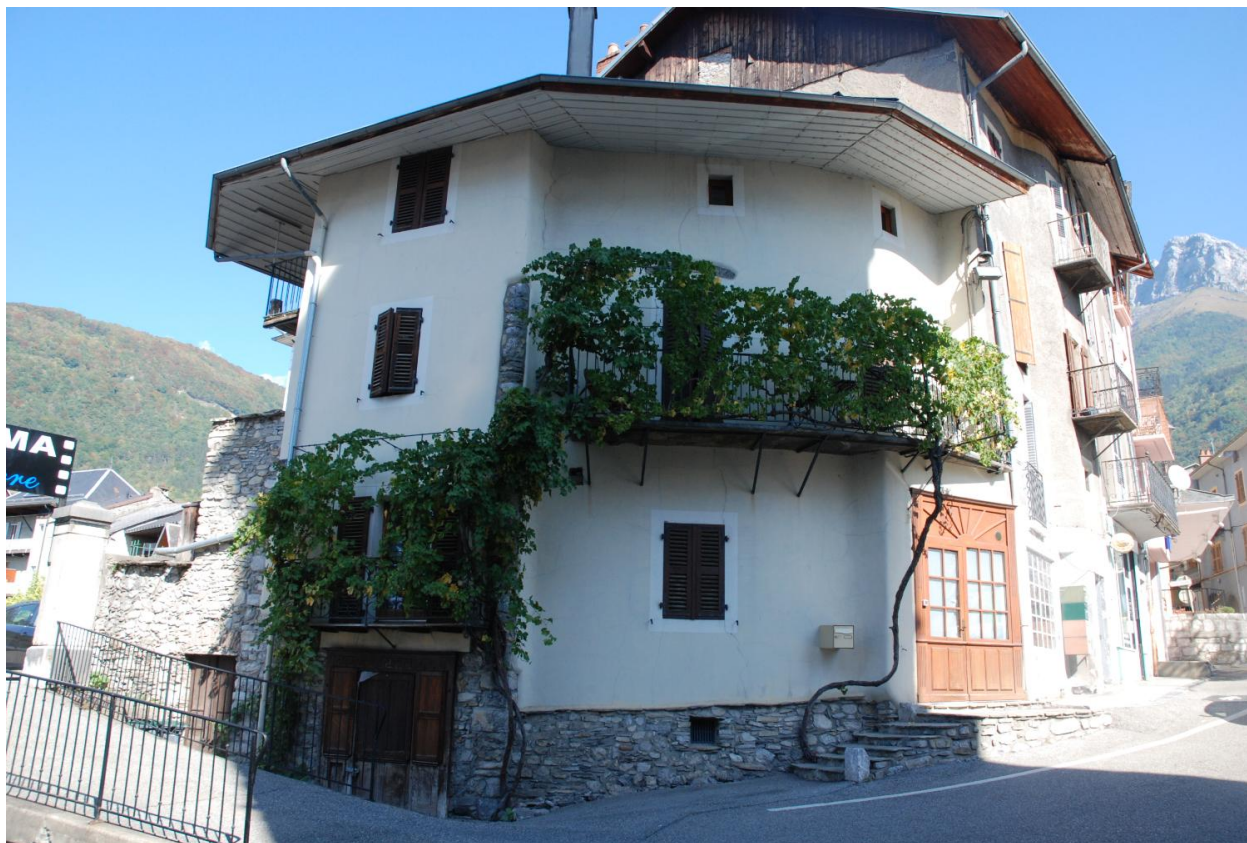
Maison, immeuble, place Charles-Albert (2018 E1 1437).
