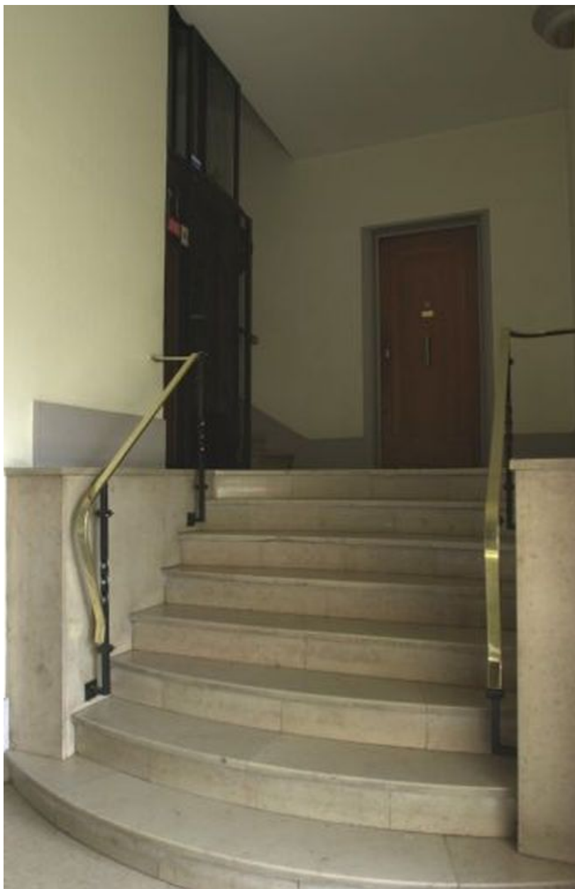
Vue de l'escalier droit du vestibule
