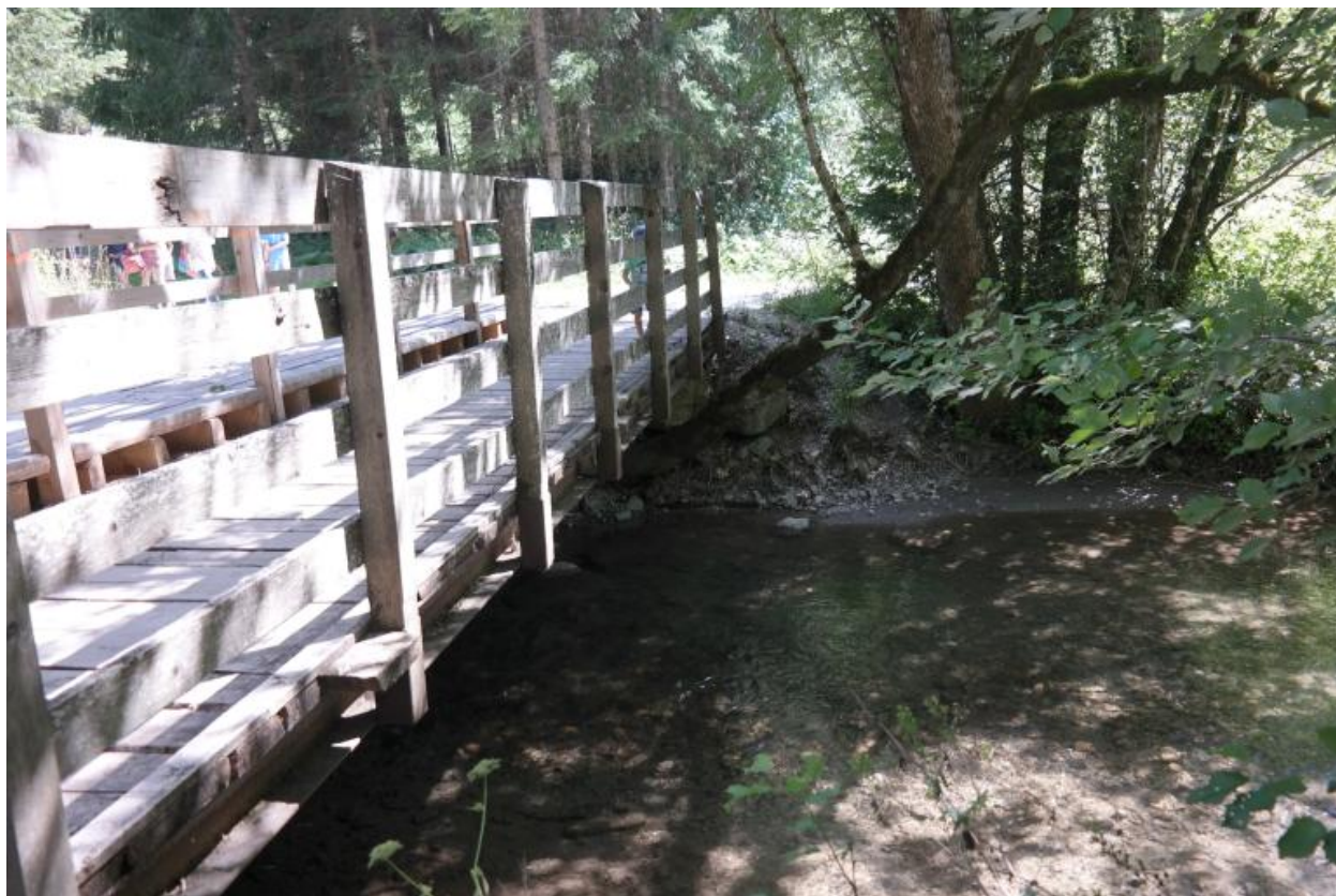
Pont du Banfin, face aval
