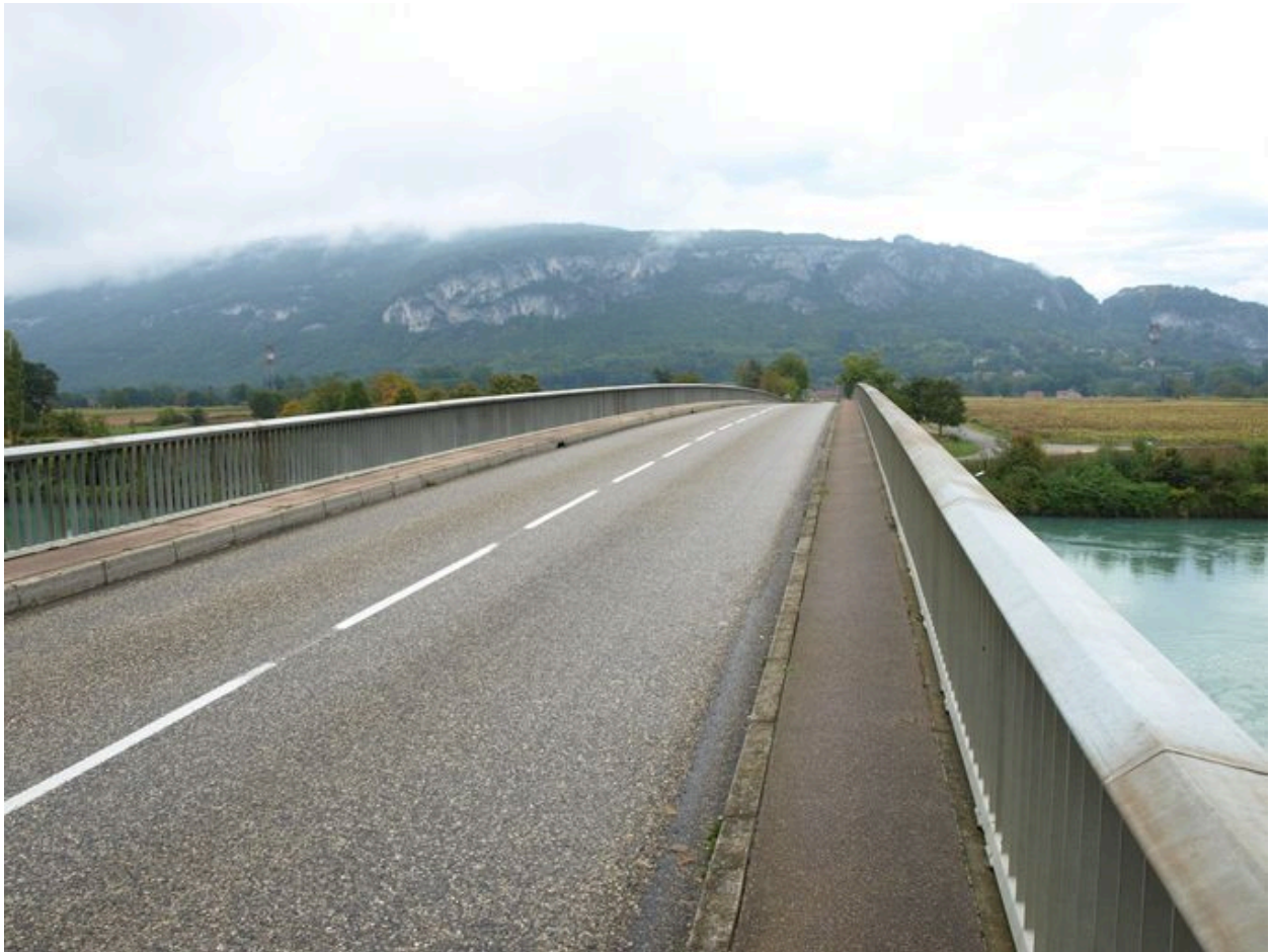
Vue de la chaussée
