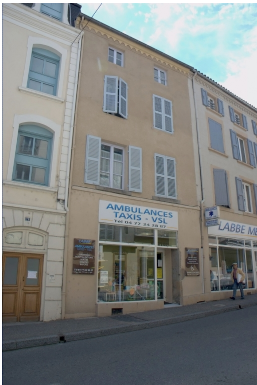
Îlot 8. Clermont (rue de) 72 / Vingtain (rue des) 06. Vue générale de la façade sur la rue de Clermont.
