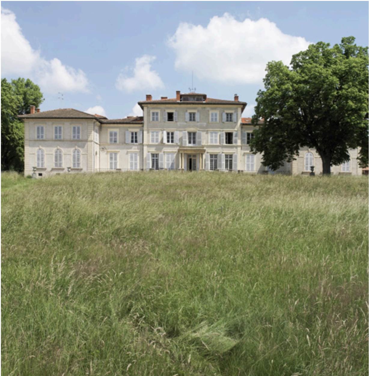
Vue d'ensemble de la façade sur jardin, depuis l'ouest.
