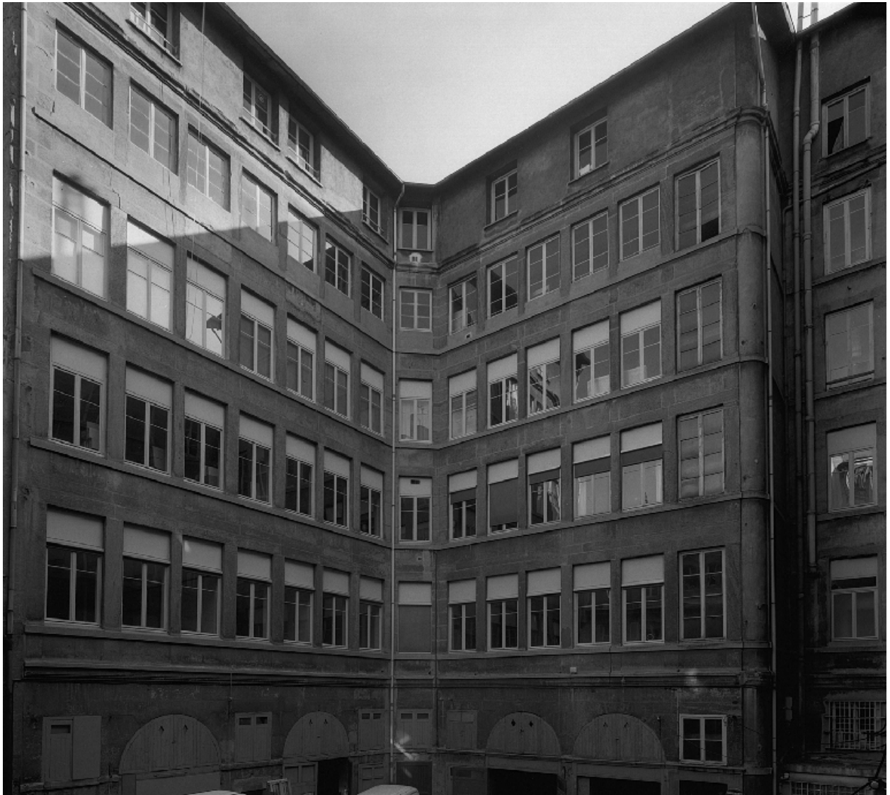
Façade sur cour
