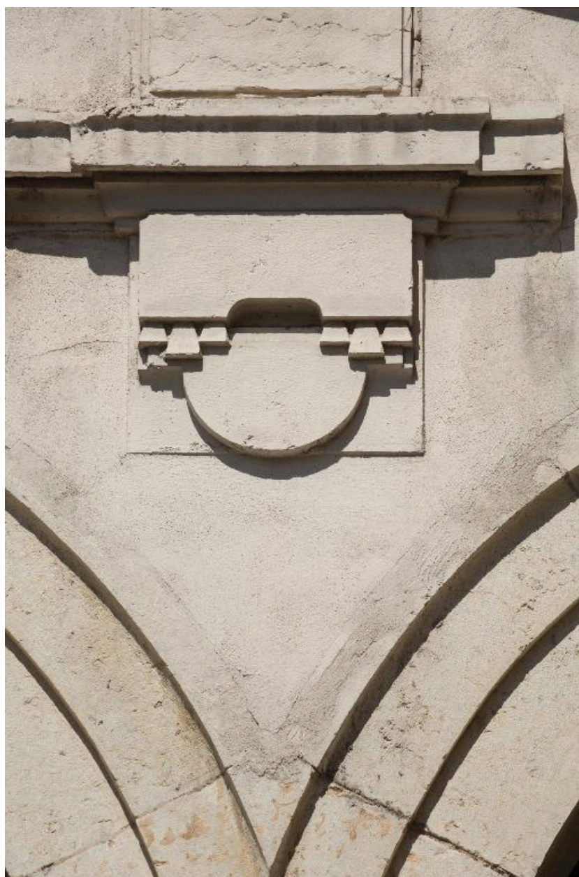
Bâtiment H côté cour, détail de modénature entre les arcades
