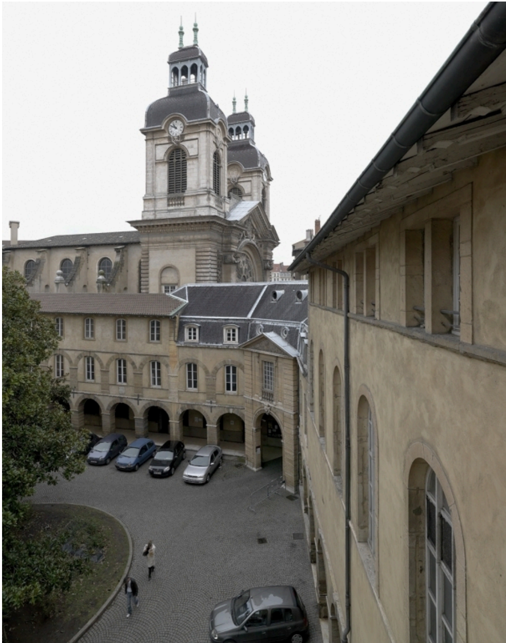
Vue depuis le nord
