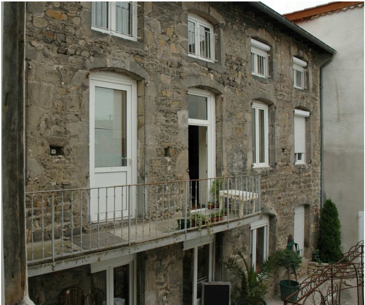
Elévation sur cour.
