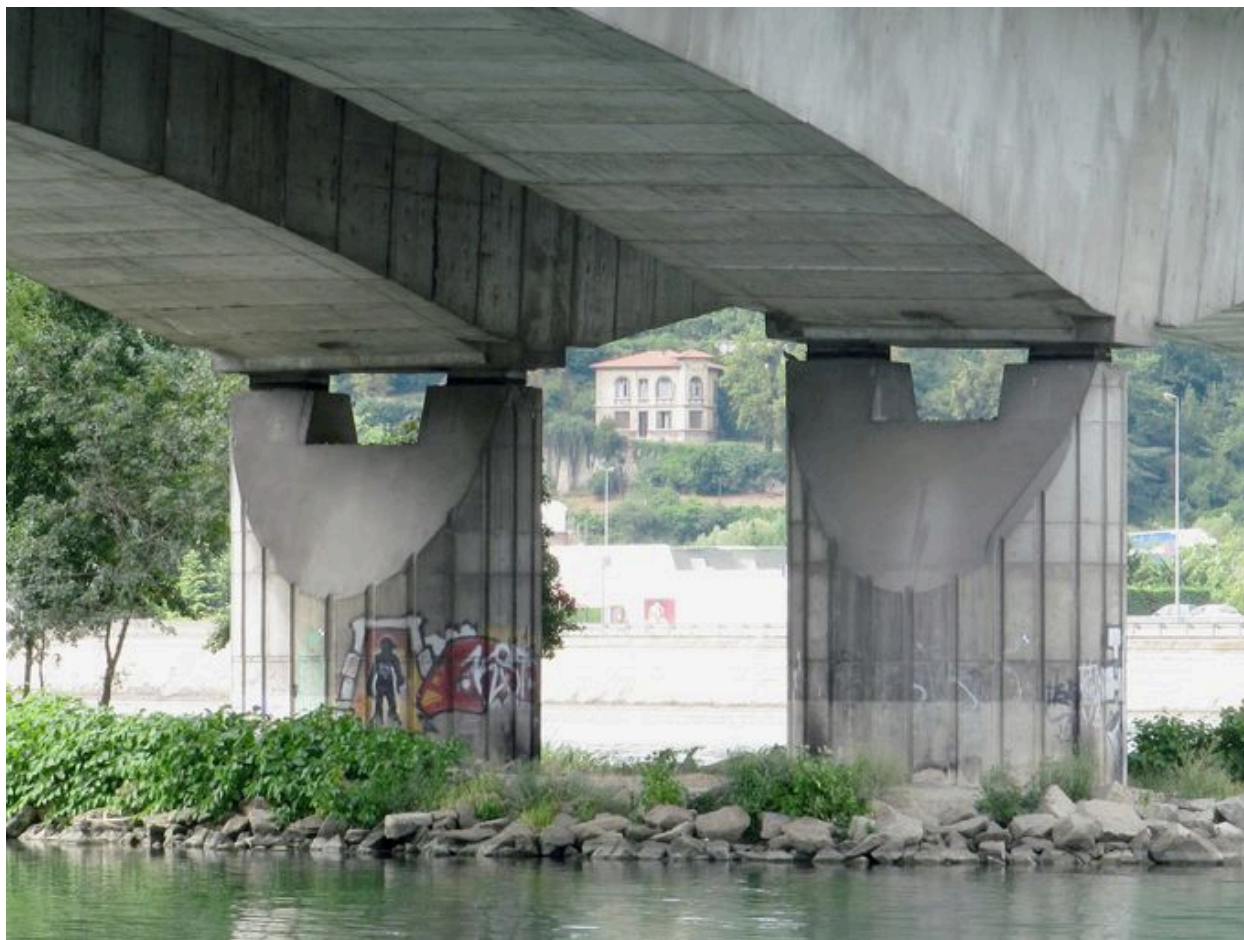
Piles (depuis la rive droite)
