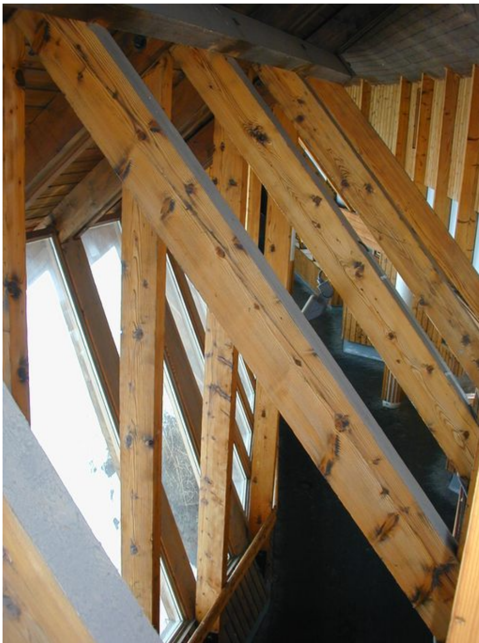
Détail de la charpente de la coursive publique
