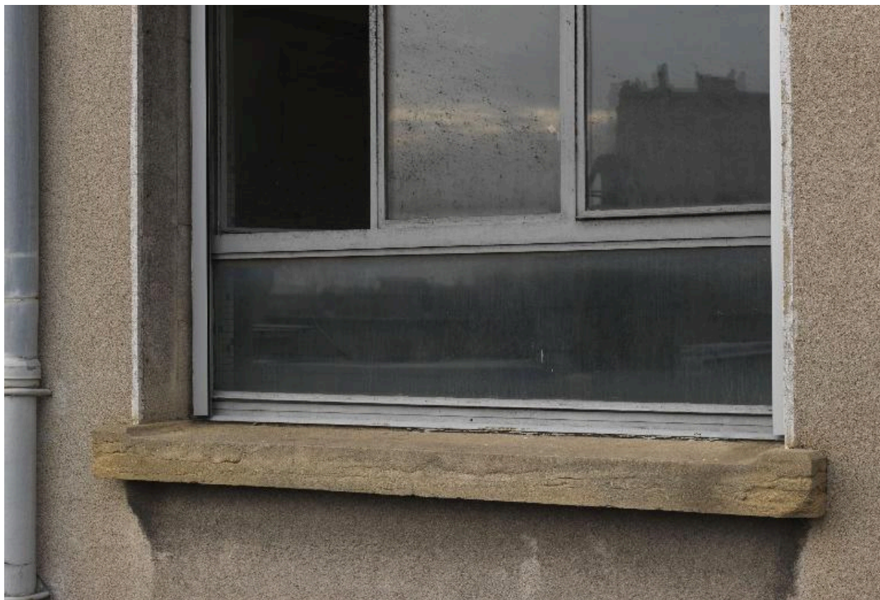
Le pavillon H en 2014 : détail d'un appui de fenêtre sur la terrasse
