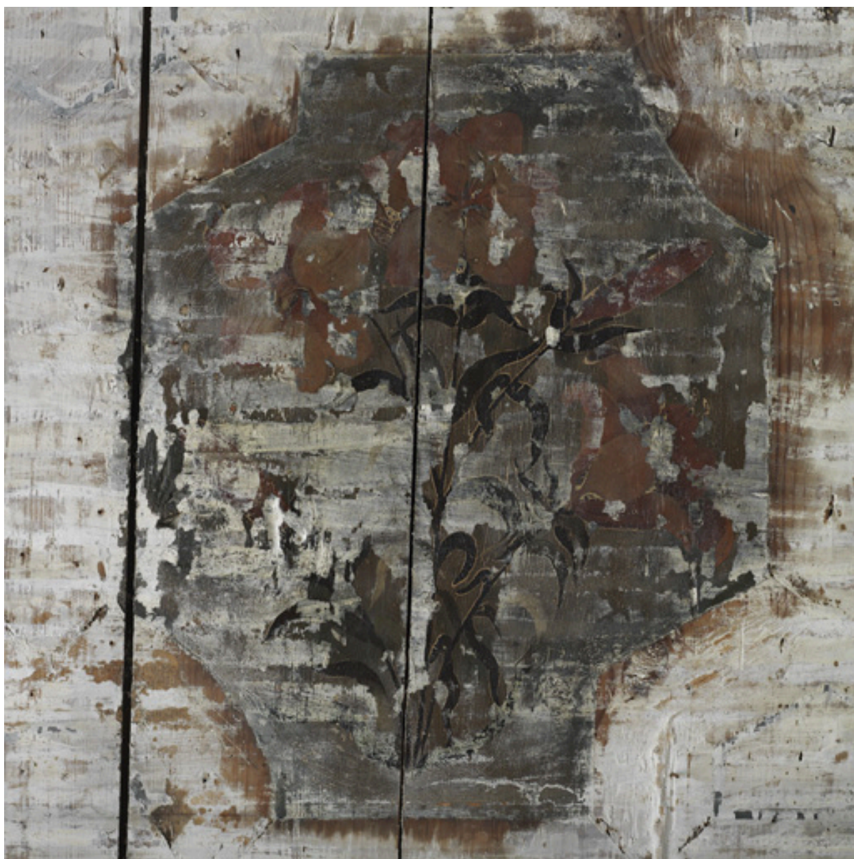
Sondage du décor peint dans les caissons.
