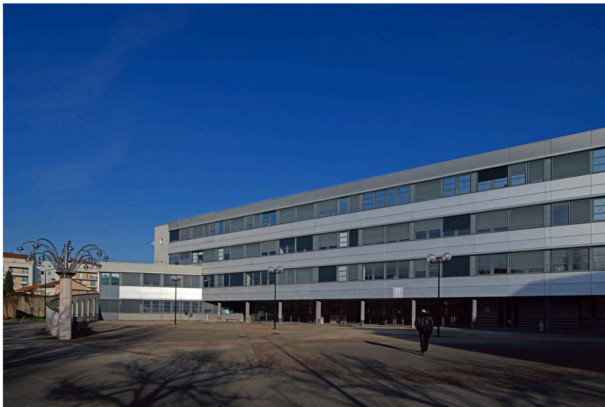
Vue d'ensemble (vers entrée B).
