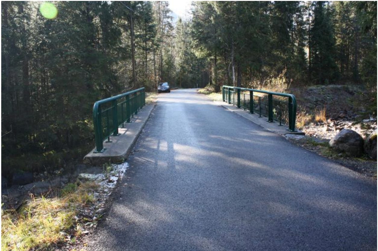
Pont de Crêt, chaussée et gardes corps
