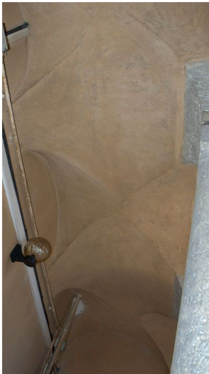
Cage d'escalier, rez-de-chaussée, détail de la voûte
