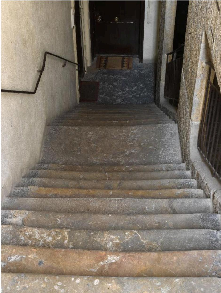
Détail d'une volée avec marche centrale plus profonde dans l'escalier du n°9 rue Dumenge commun avec le n°11
