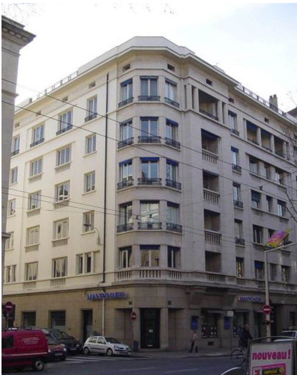
Vue générale de l'élévation
