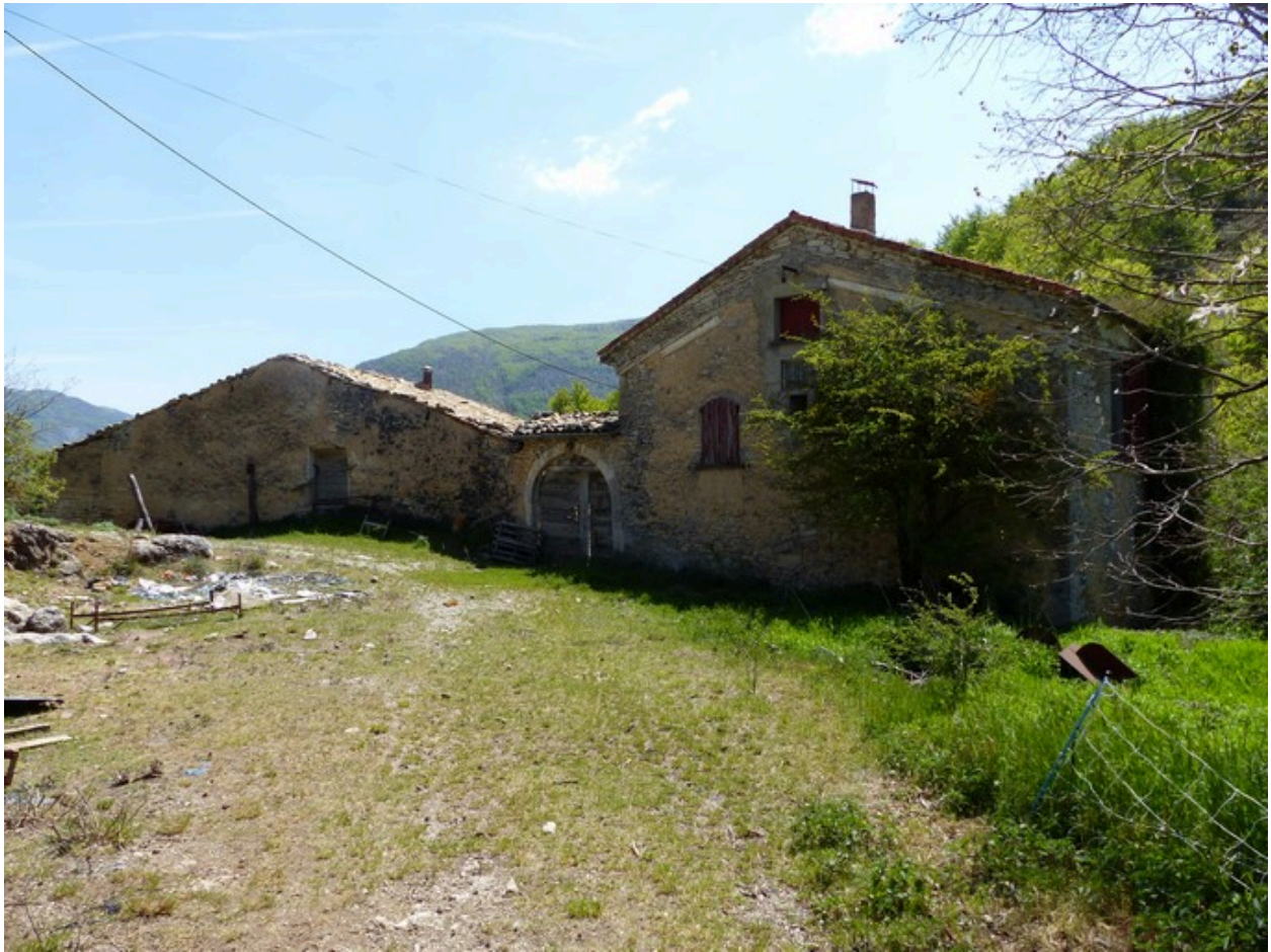
Vue d'ensemble prise du nord-ouest.
