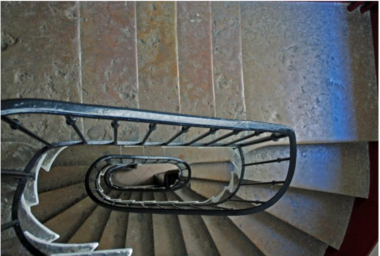
Immeuble sur cour : vue de l'escalier
