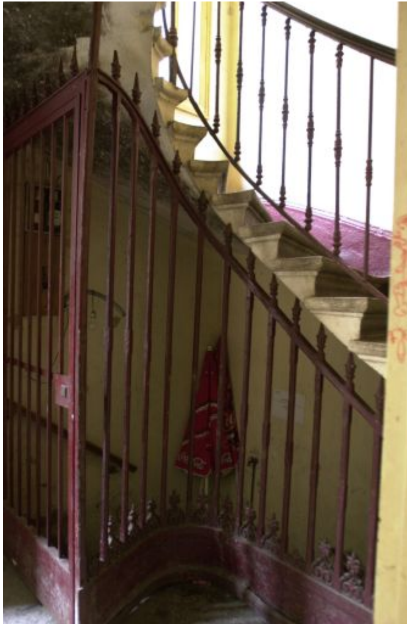
Détail de la grille fermant l'entrée de la cave, 9 cours Charlemagne
