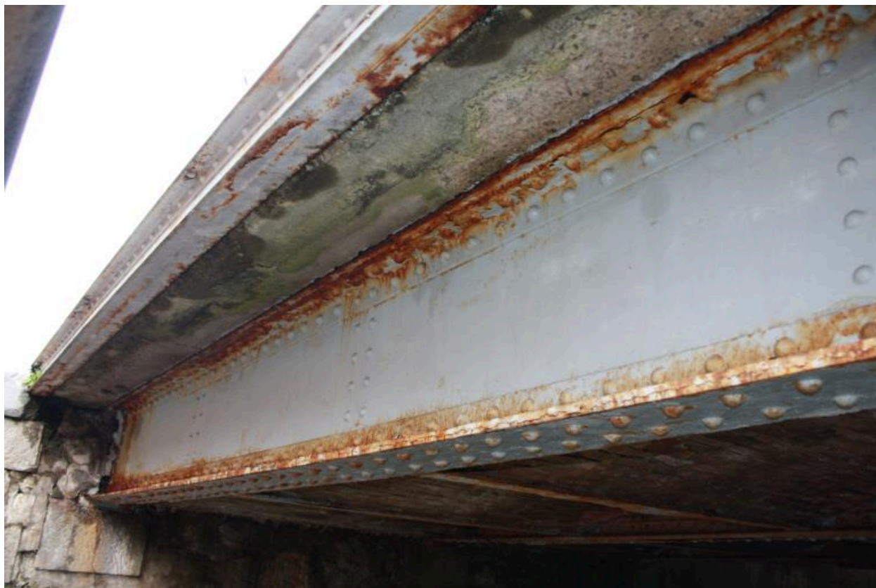
Pont du Nant Trouble, détail poutre acier
