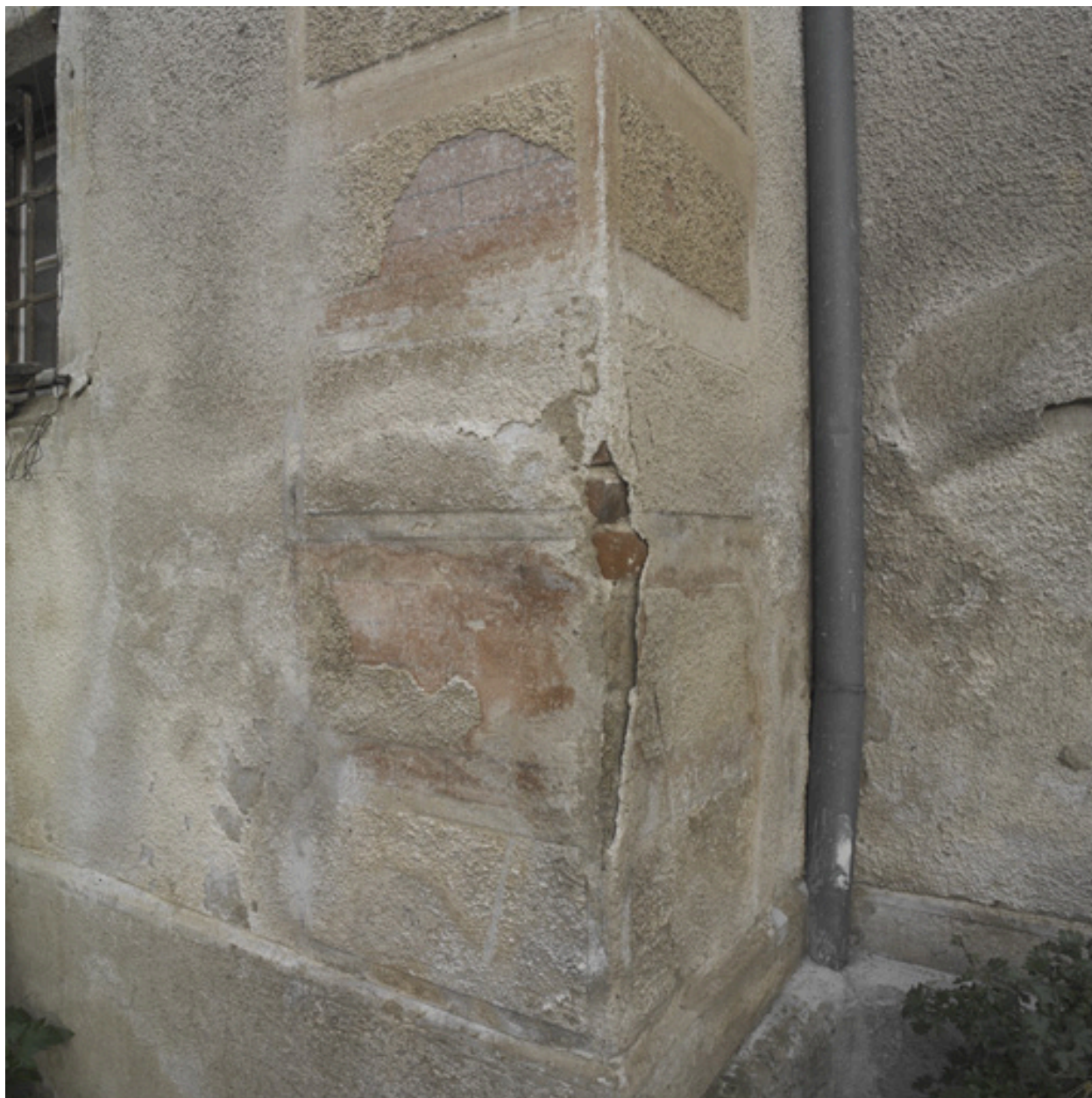
Détail de l'angle sud-ouest du pavillon nord-ouest : enduit à fausses briques peintes sous le crépi.
