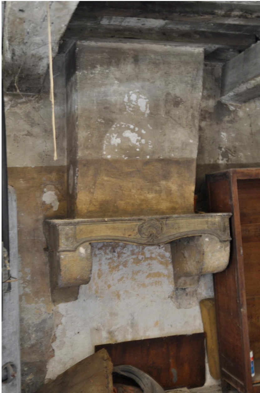
Cuisine, linteau de cheminée du 18e siècle, en remploi
