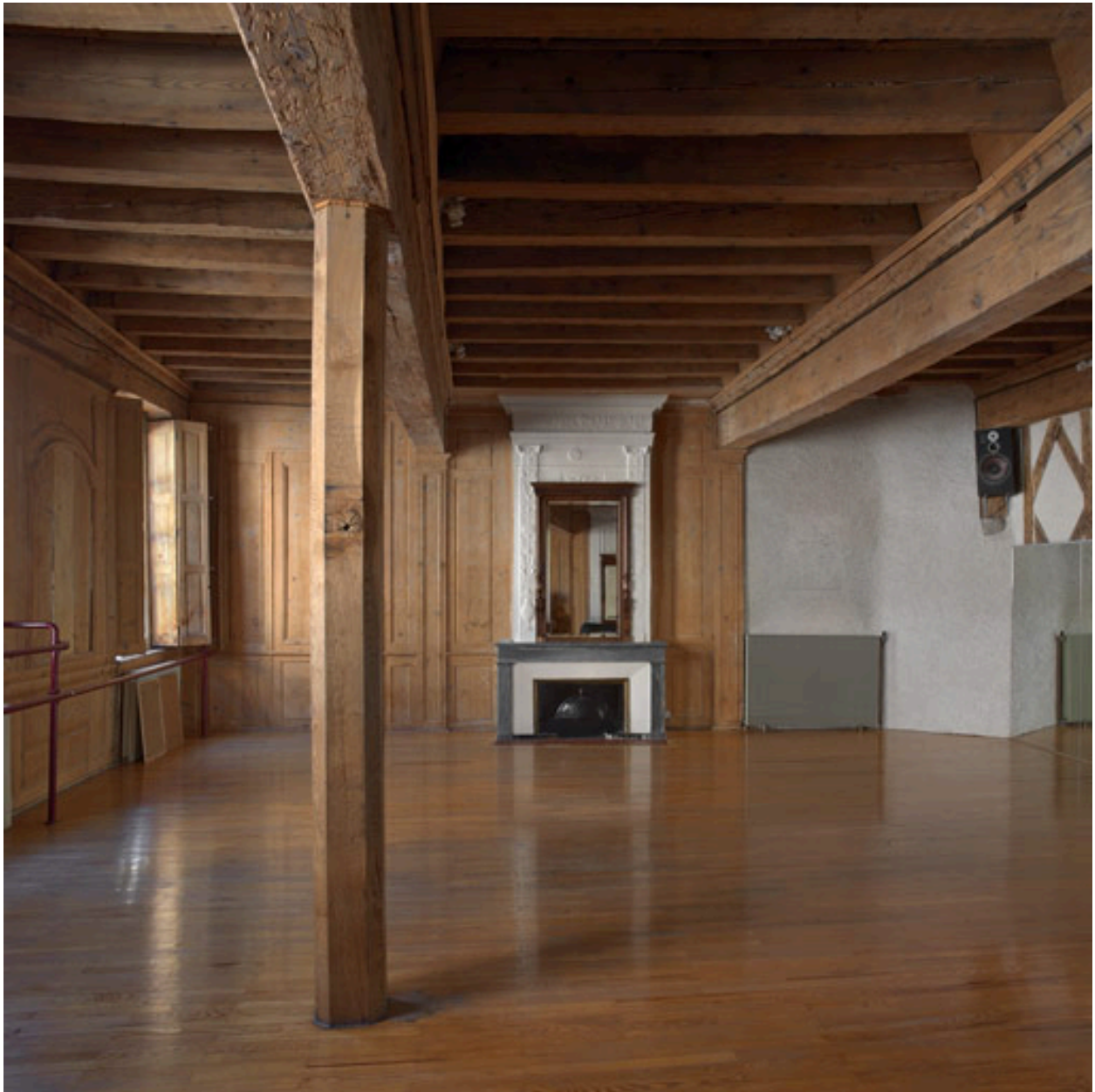
Salon du 1er étage, vue partielle.
